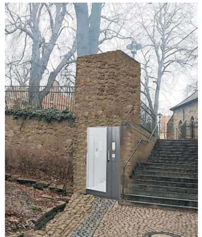
Ab heute in Betrieb: der neue Fahrstuhl an der Treppe Brunnengasse. FOTO: JUAN ZAPATERO
