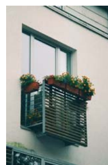
Das Gebäude in verputztem Mauerwerk ist mit einer leichten Stahlkonstruktion weiterhin zu erkennen. Die Zutat bleibt als solche ablesbar und lässt dem Hauptgebäude seine Eigenart.
