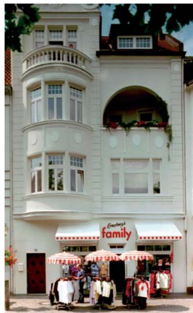
Die Fassade aus dem Historismus zeigt, dass sich ein Balkon über einem ausragenden Erker oder als (natürlich verglaste) Loggia innerhalb der Fassade durchaus unterordnen lässt.
