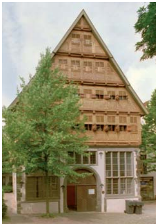
Gebäude, das mit dem Giebel dreieck parallel zur Straße steht; First und Traufen sind demzufolge rechtwinklig zur Straße gerichtet.
