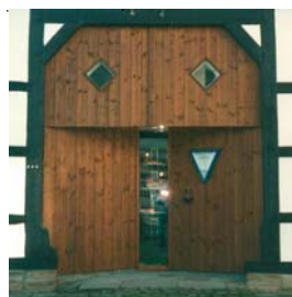
Zurückgesetzter Raumabschluss in Glas unter Beibehaltung der Torflügel in Holz
