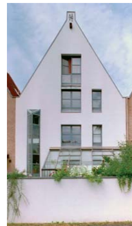
Verputz steht auch der heutigen Architektur mit ihrer Formsprache gut an und fügt sich dadurch am Standort ein.
