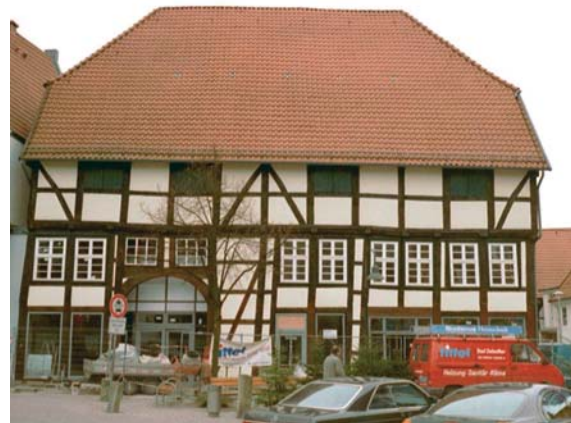
Gebäude, das mit der Dachfläche – und damit mit Traufen und First – parallel zur Straße steht; die Giebel dreiecke sind in diesem Fall als Brandgiebel zur Nachbarbebauung oder zur Seitenstraße gerichtet.
