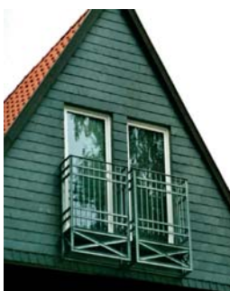
Die Anlage ist als Holzkonstruktion vor die Fachwerkfassade gestellt. Diese Form nimmt die Dimensionierungen der Fachwerkständer auf und bleibt so als Zutat weiterhin erkennbar.
