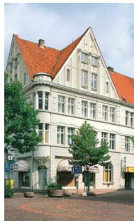
Verputz in pastellfarbenen Tönen knüpft an die vorgefundene Materialsprache an.
