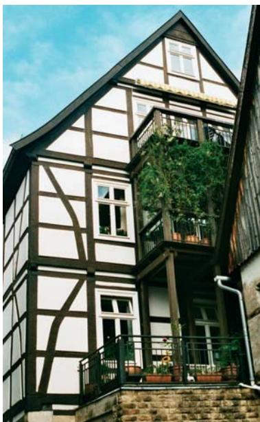
Die Anlage ist als Holzkonstruktion vor die Fachwerkfassade gestellt. Diese Form nimmt die Dimensionierungen der Fachwerkständer auf und bleibt so als Zutat weiterhin erkennbar.
