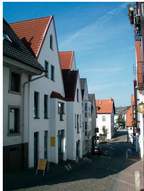
Bei wechselnden Gebäudestellungen ist ein Versprung der Traufen gestalterisch erwünscht, weil dieses zur typischen Lebendigkeit der Fassadenfolgen beiträgt. Zwischen unterschiedlichen Traufenhöhen kann neben verschiedenen Geschosshöhen besonders auch durch einen Drempel vermittelt werden.
