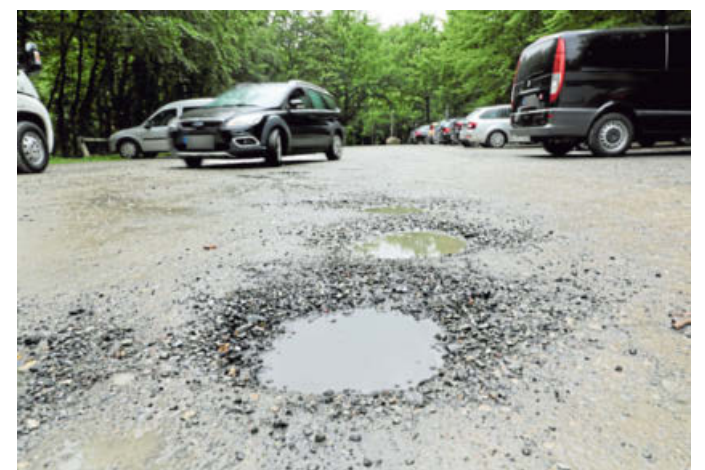
Der Parkplatz des Herforder Tierparks weist tiefe Schlaglöcher auf. Bei Regenwetter verdrecken Schuhe und Fahrzeuge schnell.
