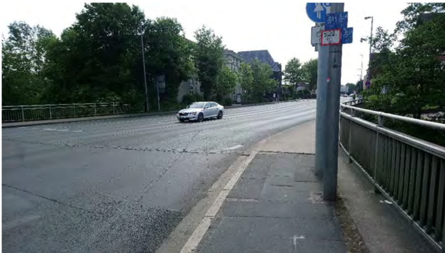
Abb. 26: Gehweg an der Rudolph-Brandes-Allee
