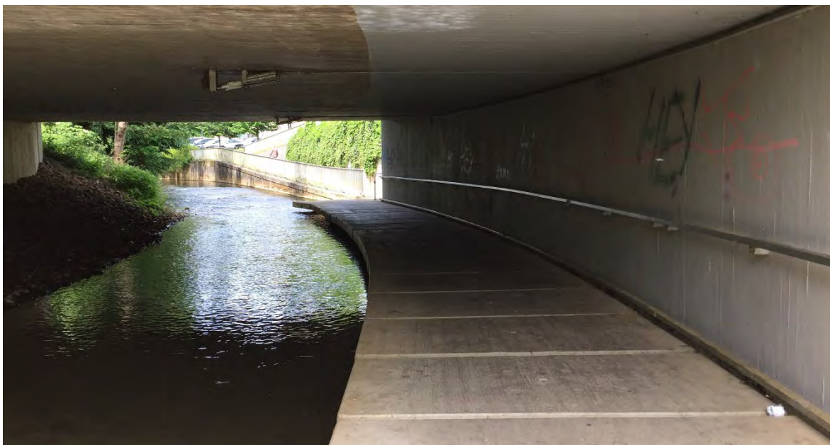
Abb. 28: Unterführung im Bereich der Bahnhofstraße
