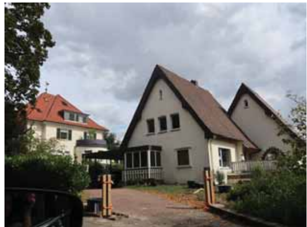
Abbildung 70 Wohnquartier Walhallastraße in hochwertiger Bausubstanz
